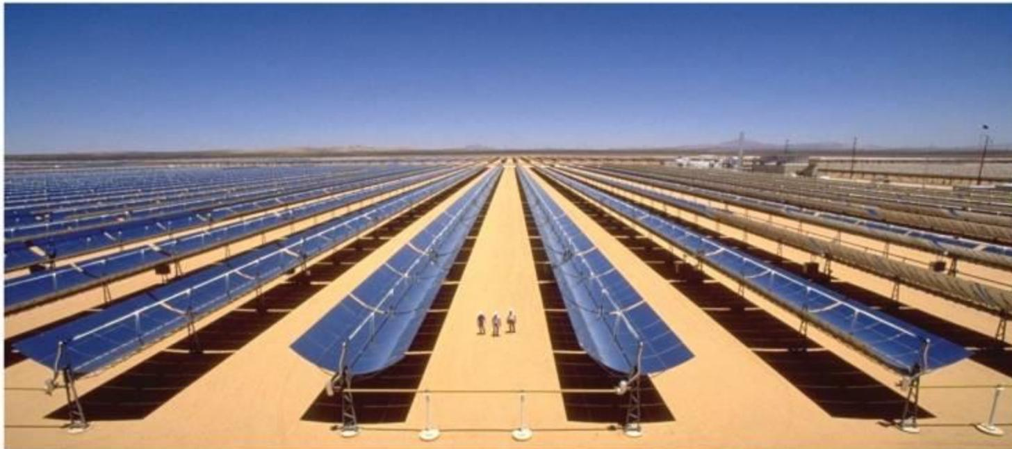
**Parabolrinnenkollektoren konzentrieren die solare Strahlung und erzeugen Hochtemperaturwärme (400 °C). Das Foto zeigt einen Ausschnitt aus dem größten Solar kraftwerk der Welt in Kalifornien.**
