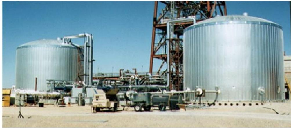
Wärmeträgerfluid:  $\text{NaNO}_3$  (60%)/ $\text{KNO}_3$  (40%)
